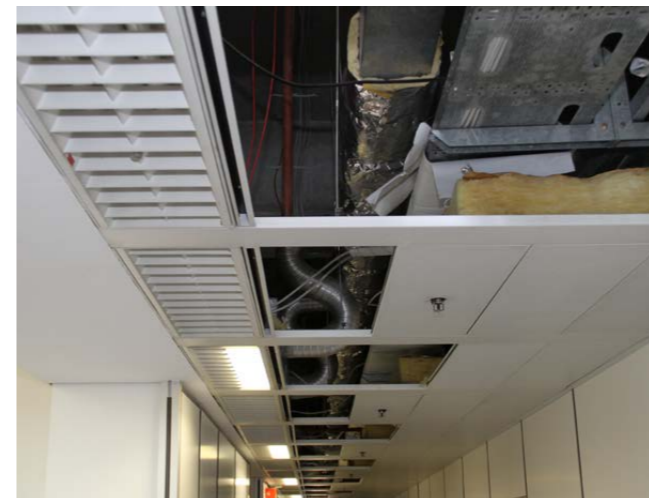
Um im Ernstfall eine Brand- und Rauchentwicklung einzudämmen, wurden die bislang durchgehenden Leitungsschächte unterteilt.
