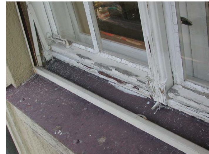
Die Fenster am Verwaltungsgebäude Holbeinstraße mussten saniert werden.
