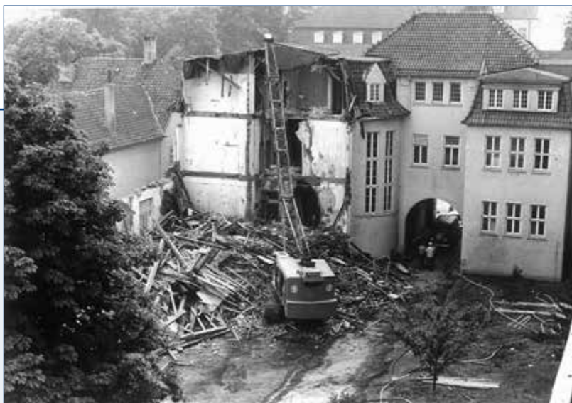
Abriss des bekannten „Torbogenhauses“ der Hauptverwaltung in Oldenburg (1975)
